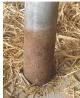
La corrosion dans les bâtiments d'élevage est fréquente à cause des agents agressifs et de l'environnement. Penser à brosser et peindre avec une peinture bitumineuse dès l'apparition des premières traces.
