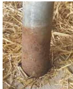
La corrosión en las naves ganaderas es frecuente debido a los agentes agresivos y al medio ambiente. Recuerde cepillar y pintar con pintura bituminosa en cuanto aparezcan las primeras marcas.
