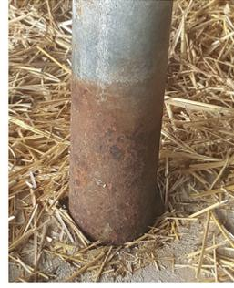
Korrosion ist in Stallanlagen aufgrund der aggressiven Stoffe und Umgebungsbedingungen weit verbreitet. Denken Sie daran, die entsprechenden Stellen zu bürsten und mit einer Bitumenfarbe zu streichen, sobald die ersten Spuren sichtbar werden.
